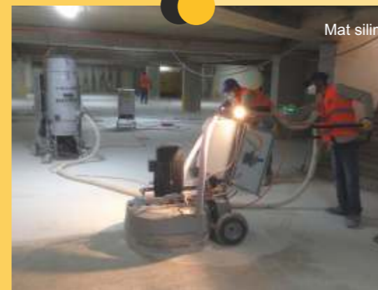
Samsun Başoğlu İnşaat - Arcadia Park Sitesi Otopark
