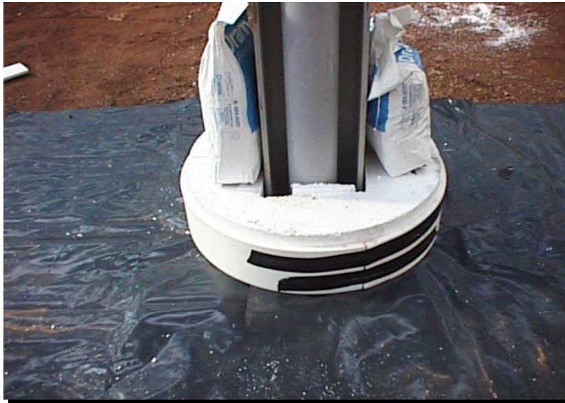
Resim...5....Çelik kolon etrafında düzenlenmiş bir izolasyon derzi
