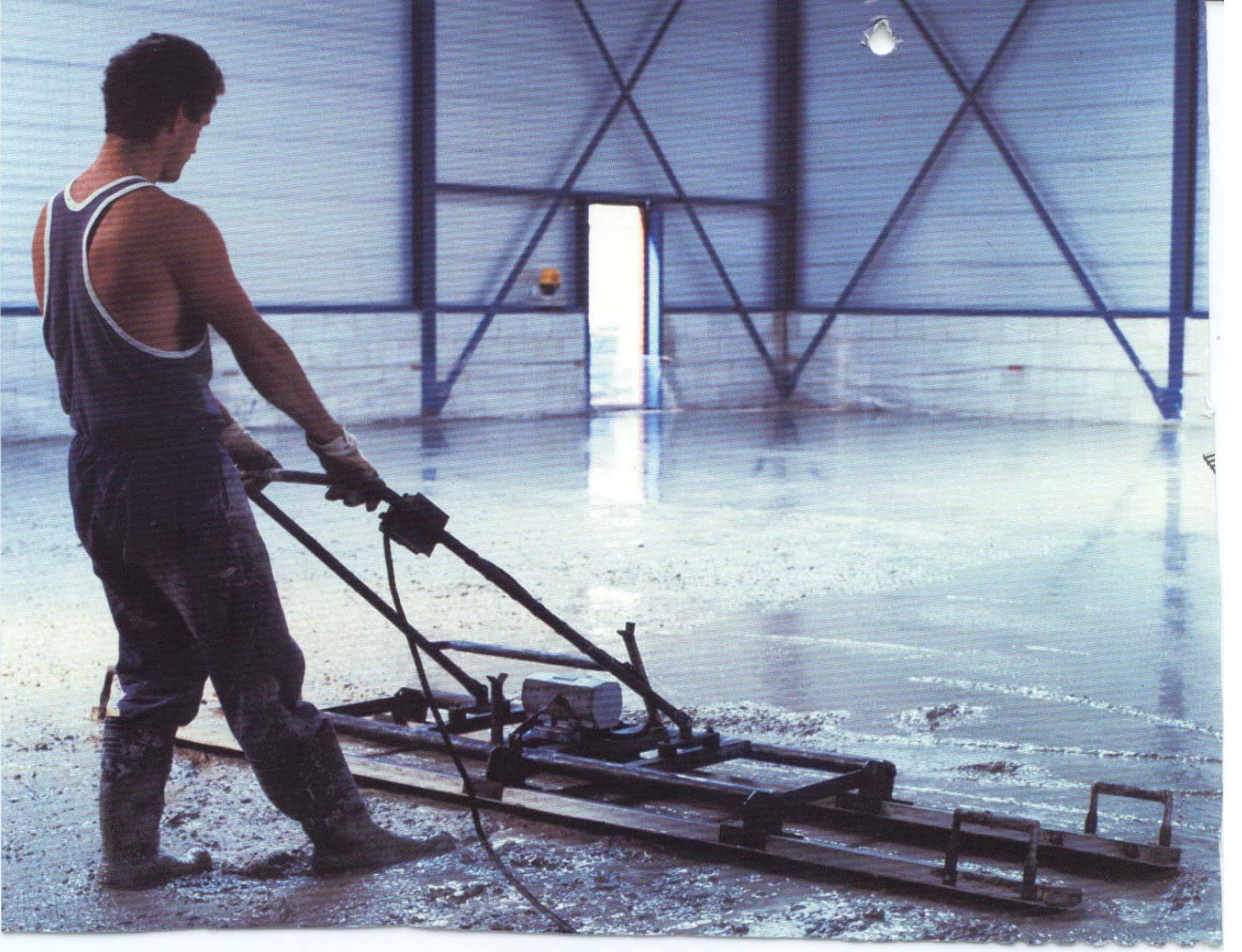
Resim 11. Kendi kendine yayılan zemin betonları için yüzer master ile yüzey perdahı yapılması.
