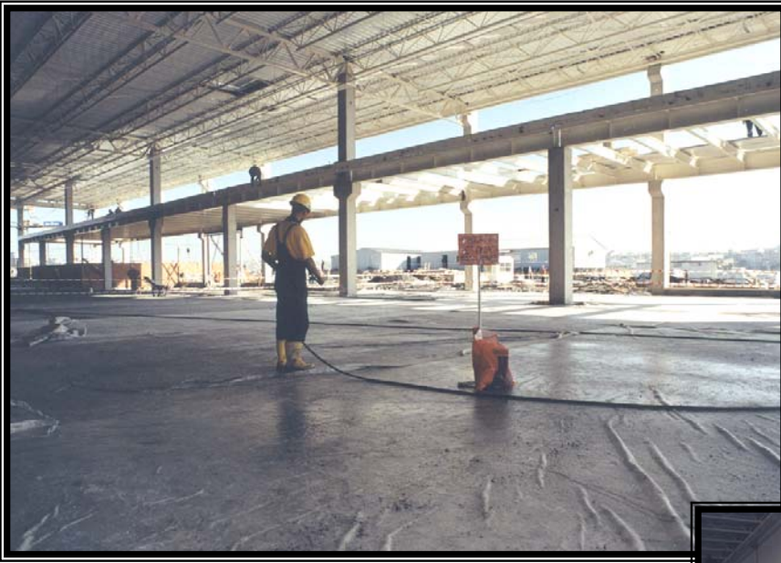
Resim 8 Beton yüzeyin ıslak örtü ile korunması
