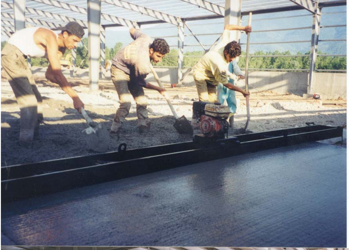
Resim. 1 – Vibrasyonlu master kullanarak uzun şerit döküm yapılması (İzmit.2001)
