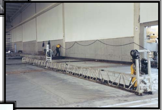
Resim 9. Vibratörlü yüzey mastarı
