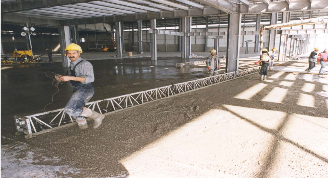
Resim2...Geniş şerit döküm. Master açıklığı 16 mt.
