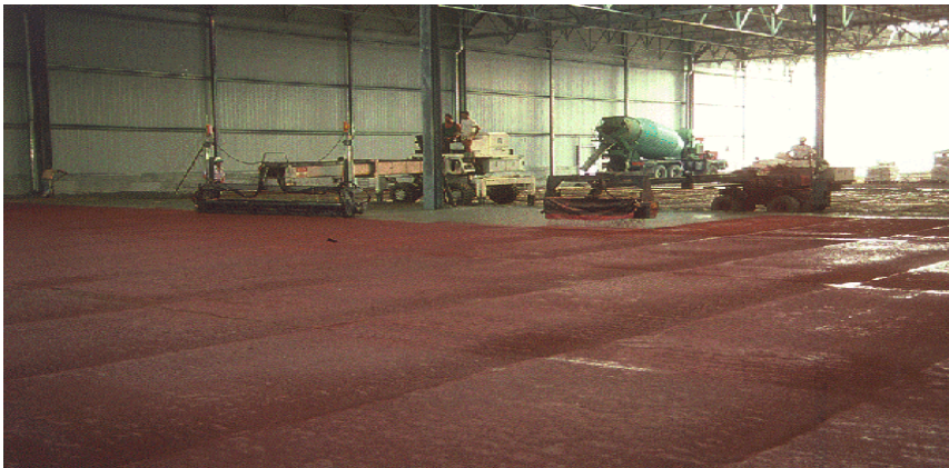
Resim ...4.. Lazer kontrollu tesviye makinası, yüzeye sertleştirici seriyor.
