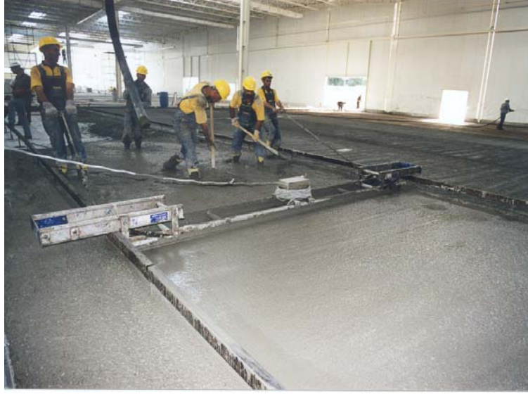
Resim 3.... Geçici çelik master kullanarak geniş alanların dökümü .Arka planda,geçici ayakları görebilirsiniz.
