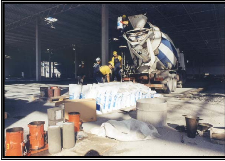
Resim 7 Çelik Tellerin Şantiyede Transmiksere İlave Edilmesi
