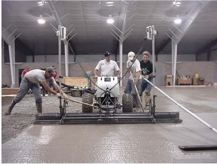
Resim 12 . Laserli master kullanarak zemin perdahı. (USA2003)
