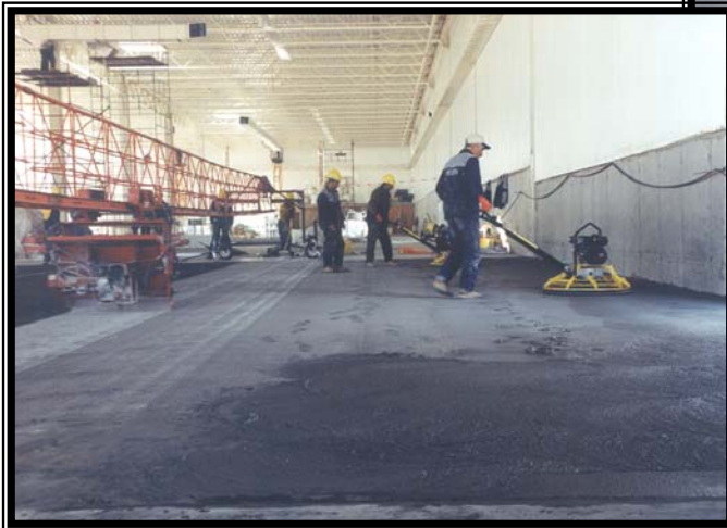
Resim 10 Yüzeye sertleştirici serilmesi
