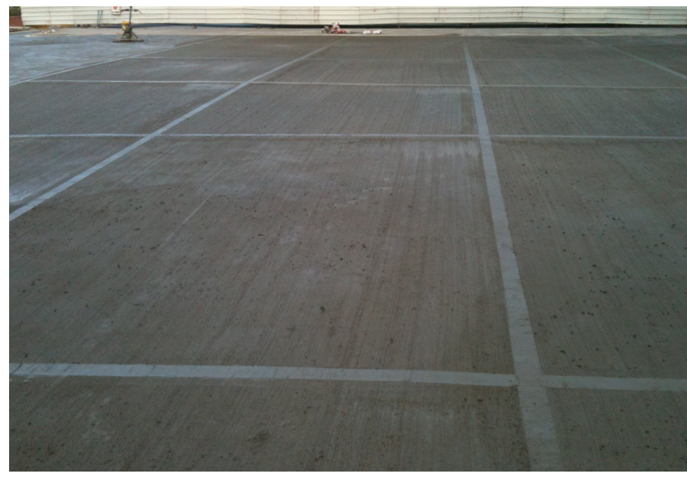
Şekil 5. Derz Kesimi Yapılmış Saha Betonu
