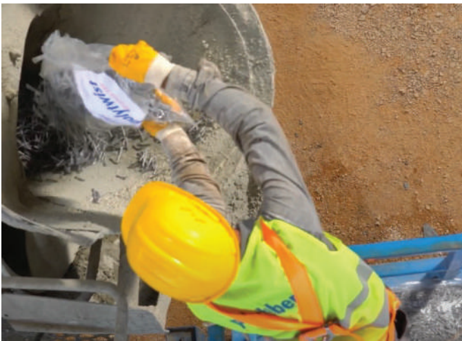
Şekil 7. Belirlenen Dozajda Fiber Donatının Beton Mikserinde İlavesi
