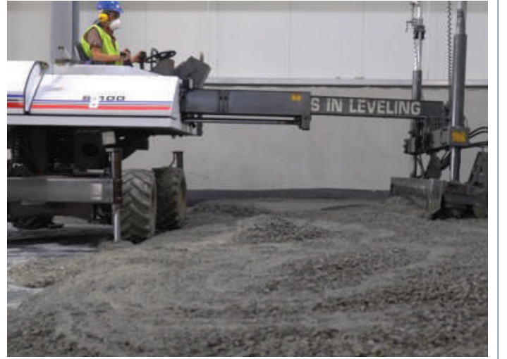
Şekil 4. Laser Screed Makinesi ile Beton Dökümü
