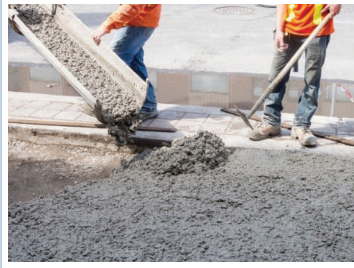
Şekil 3. Örnek Beton Döküm Yüksekliği
