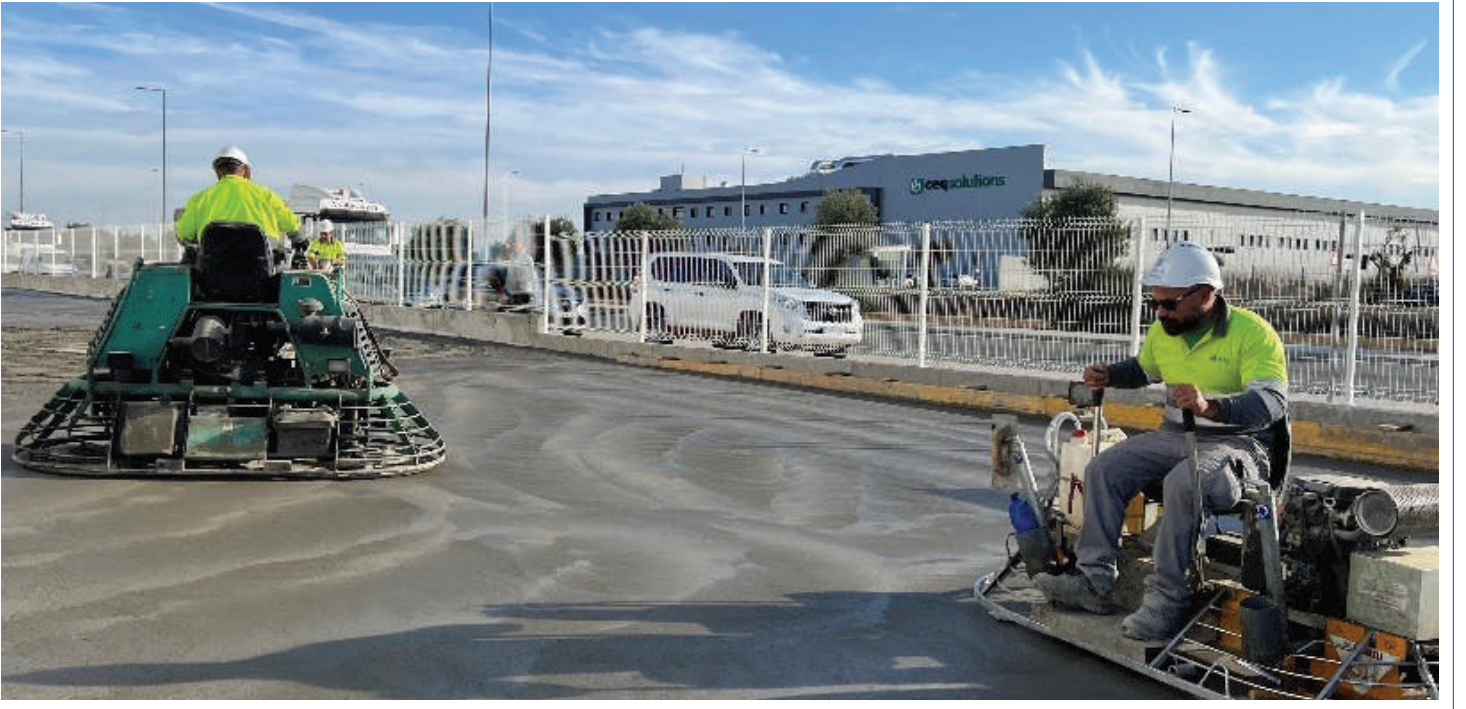
Şekil 5. Helikopter Perdah Uygulaması
