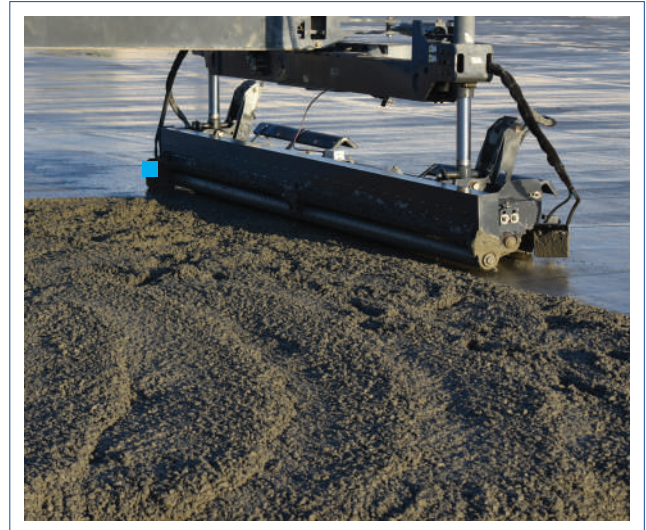
Şekil 2. Zemin Betonu Uygulaması
