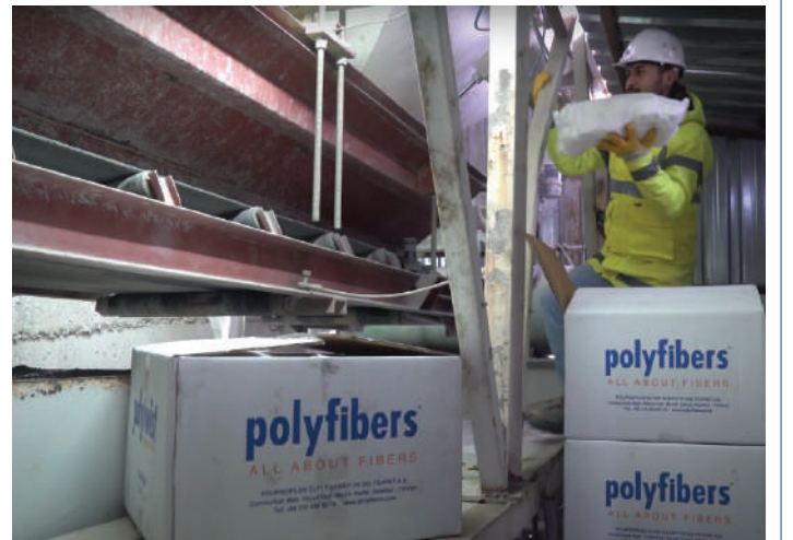
Şekil 8. Belirlenen Dozajda Fiber Donatının Agregada Bandında İlavesi
