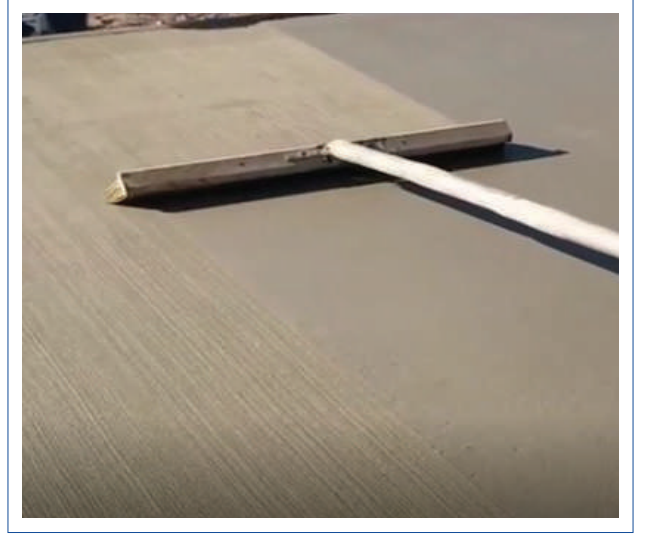
Şekil 6. Süpürgeli Beton Fırçası Kullanımı
